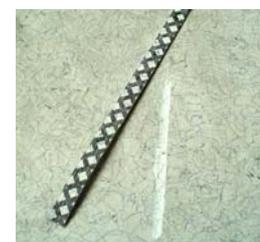
2. Ajuste la temperatura del soldador a 450°C aproximadamente. Deslice la tira a través de la boquilla de soldadura, con el dorso hacia arriba. Antes de proceder, compruebe la temperatura en la tira de Colorex; el material debe ablandarse, pero sin derretirse ni tostarse.
