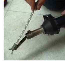
3. Suelde con firmeza la tira en la ranura. Proceda muy poco a poco, haciendo diversas paradas y asegurándose de aplicar la presión adecuada sobre la boquilla de reparación. Al finalizar, tire firmemente de la tira de Colorex para comprobar el resultado. Si la tira se desengancha con facilidad, empiece de nuevo y ajuste una temperatura más elevada.
