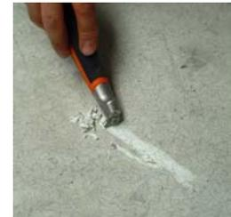
5. Cuando se haya enfriado, rebaje el material de soldadura con el saneador de juntas excéntrico. Empiece con un papel de lija grueso (120) y proceda en varios pasos hasta 240.
