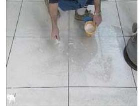
2. Retire el agua sucia con la aspiradora industrial para líquidos. A continuación, enjuáguelo con agua limpia para eliminar el polvo de la abrasión, y pase la aspiradora. Llegados a este punto, el pavimento se verá limpio, pero la superficie quedará áspera y precisará restauración.
